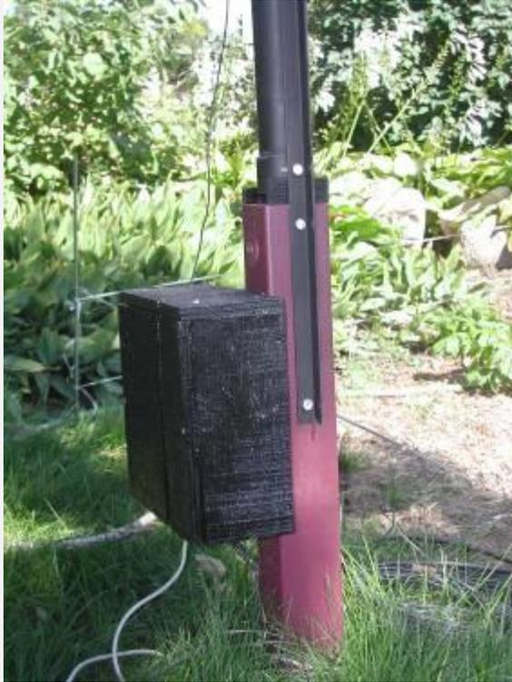
Quando la struttura è orizzontale, il bullone inferiore viene rimosso. La struttura è sollevata ruotando su bullone superiore. Una volta che la struttura è verticale, viene installato il bullone inferiore. L'installazione è un po' complicata perché a un piccolo movimento sul bullone inferiore provoca un grande movimento nella parte superiore della struttura (45 piedi più in alto).
