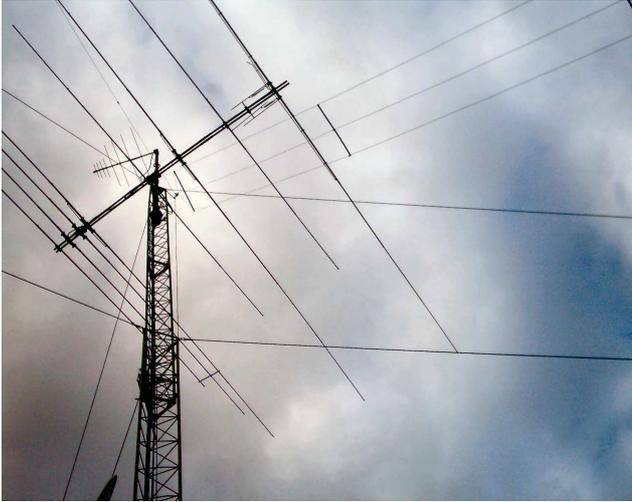
Le prove sul campo hanno prodotto risultati confortanti. La banda passante con  $ROS < 2:1$  e' ben superiore all'intervallo di frequenza a noi riservato in 160m (1830-1850 kHz).
